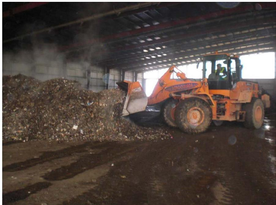
Figura 0.8. Volteo de la pila mediante la pala.
