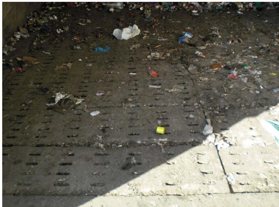
Figura 0.16. Vista del suelo del túnel y las toberas para la salida de aire.
